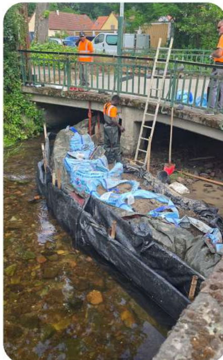
Pont salle des fêtes : déviation du cours d'eau pour assécher les fondations afin de réaliser les réparations
