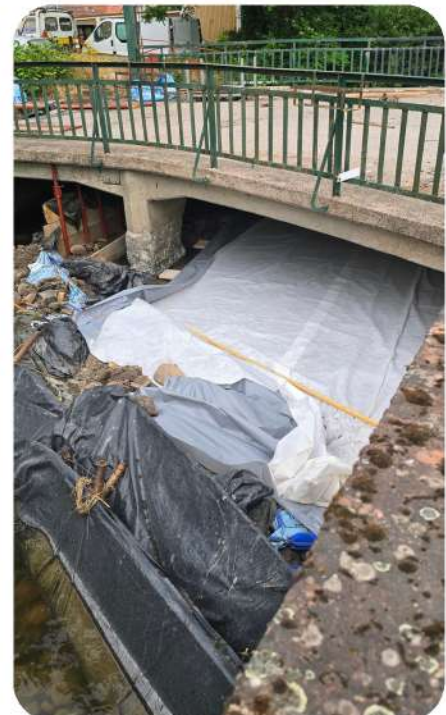
Pont salle des fêtes : mise en place d'un platelage pour la récupération des déchets et éviter la pollution de la Hasel
