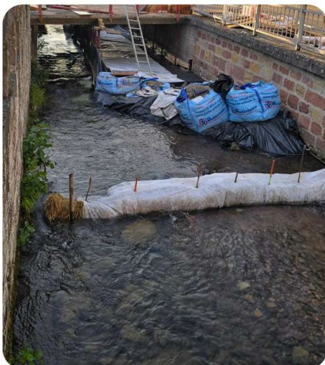
Pont rue de la Rivière : mise en place d'un barrage flottant pour la récupération des déchets
