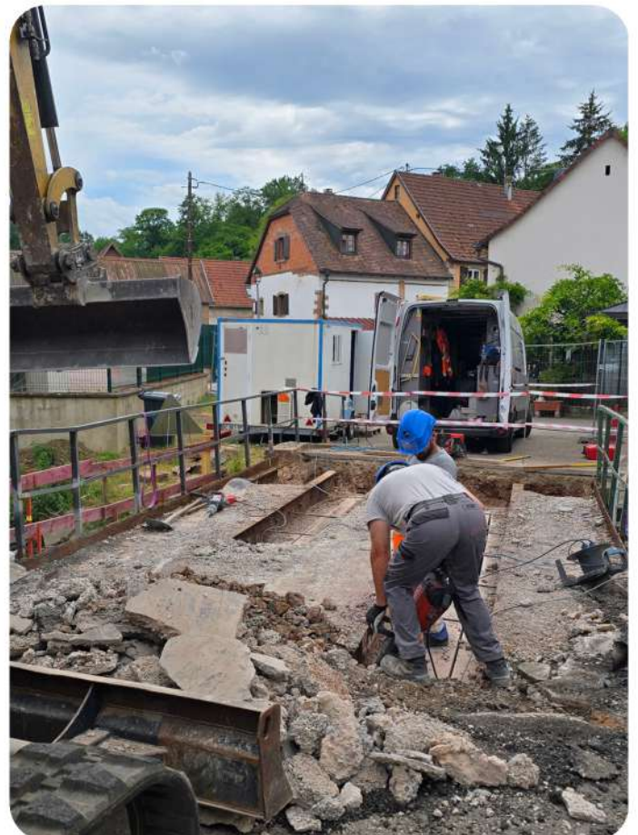
Pont rue du Coin : début de la démolition du pont
