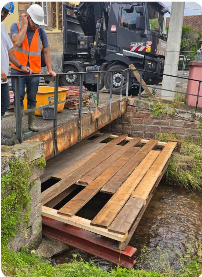
Pont rue du Coin : mise en place d'une structure métallique et de madriers en bois pour la récupération des déchets
